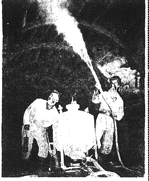
Jedną z form ochrony bezpieczeństwa pracy w kopalniach przed wybuchem pożaru jest opylanie chodników i robót pyłem kamieniem. Na zdjęciu: opylanie chodnika pyłem kamieniem w kopalni „Anna”. CAF — fot. Tymiński
